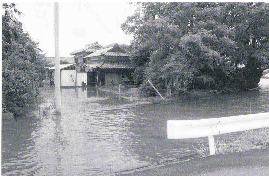
高潮の被害を受けた民家（伊上）
