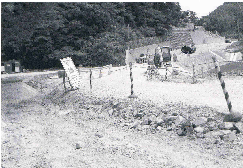
建設中の萩・三隅道路（三隅地区）
