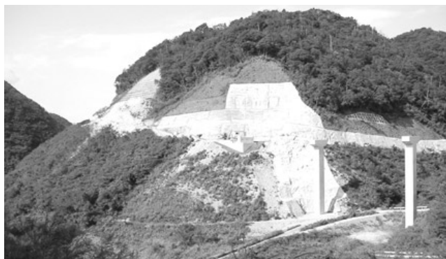
大河内川ダムの建設現場
