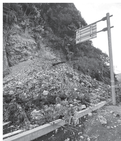
▲被災した依山地区の市道湯町5号線
