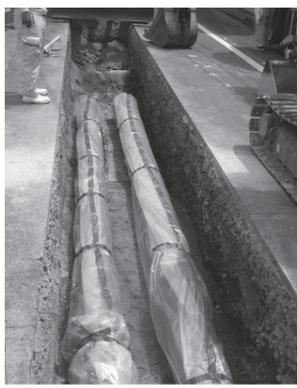
▲老朽化した水道管を新しいものに取り替える更新工事
