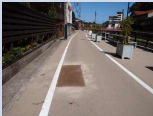
おとずれ通りの道路補修
