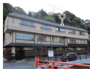
○通り沿いは傾斜屋根とし、背後の陸屋根部分に設備機器を隠す工夫
