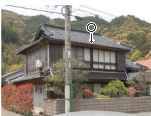
○アルミサッシで連続窓を実現した例
