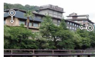
○軒の出の確保、水平線の強調、手摺の設置など風情を出す様々な工夫
