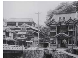
昭和初期の恩湯と枕水の外壁は板張り。軒下は真壁木組み現し
